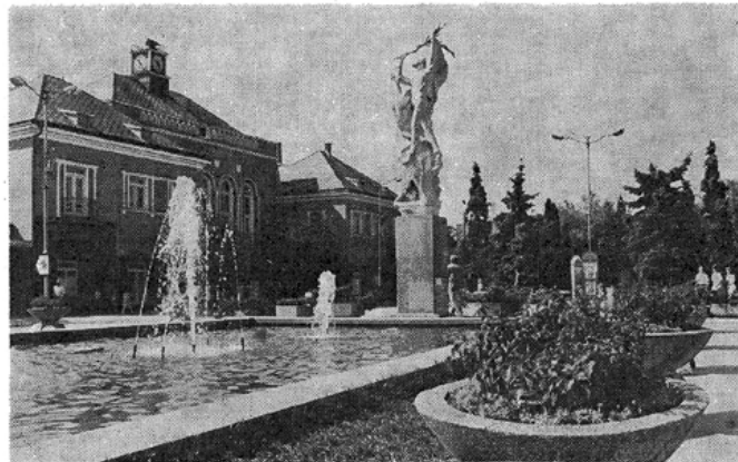
Pohľad do centra okresného sídla — na námestie Osloboditeľov (v pozadí budova MsNV). Snímka: Stano Ortolin
